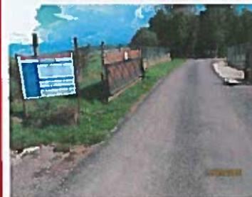
Réparation au point à temps des trous 390M<sup>2</sup>. Scarification des zones indiquées 220m<sup>2</sup> Mise en œuvre d'ECF bicouche 1820 m<sup>2</sup>
