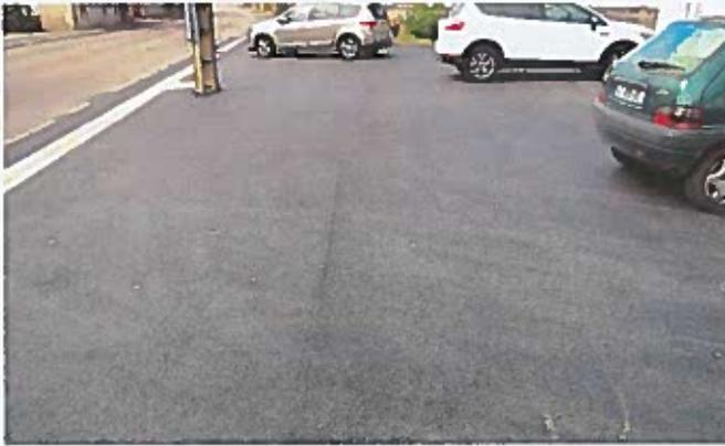
Réfection du parking de la poste et du trottoir en enrobé pour 280 m<sup>2</sup>. Démolition de bordure AC1 et pose de caniveau CCI sur 30 ml. Rue des crêts réparation en point à temps et enduit bicouche pour 1 100 m<sup>2</sup>
