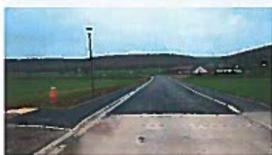
Création de bordure de trottoir en bordure P2 et T2 sur 300m, caniveau CS1 sur 90 ml et réalisation de la route en enrobé.
