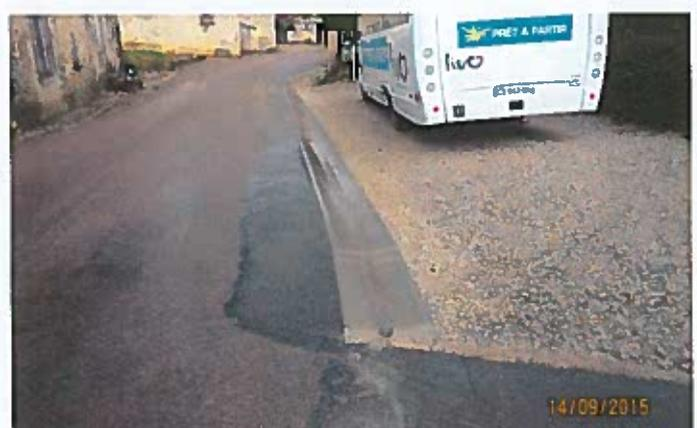
**Pose d'un caniveau en CC2 sur 36 mètre de long**
