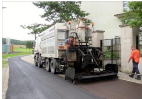
Bande de roulement : scarification, monocouche et ECF (enrobé coulé à froid) ou bicouche
